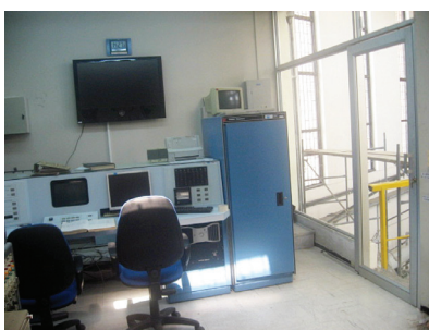
Foto 4. Nueva división en vidrio templado y película de seguridad de la sala de control.
