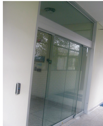
Foto 2. Puerta de acceso al reactor.
