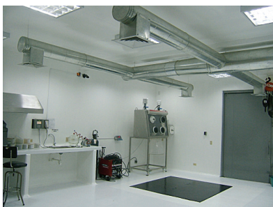
Fotografías. Almacén 2 de desechos radiactivos.
