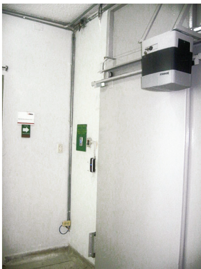
Foto 3. Nuevo motor y control de apertura de la puerta del recinto del reactor.
